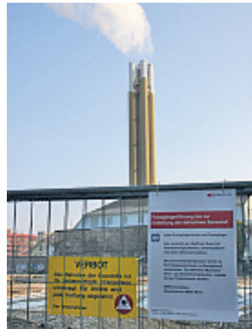
Das Hinweisschild am Bauzaun «Südpark». Foto: GZ.
