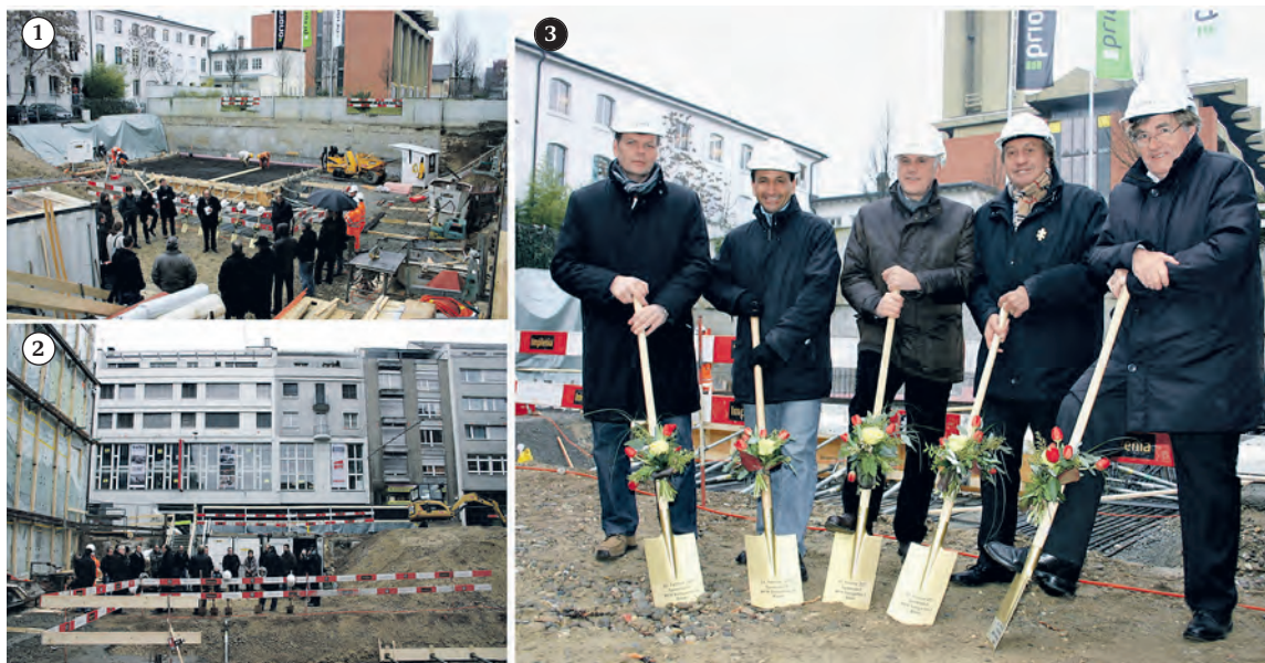
1) Die Baugrube des entstehenden Neubaus «Sologarten II» an der Güterstrasse 149. 2) Blick Richtung Güterstrasse (vis-à-vis Casa Hirsbrunner). 3) Traditioneller Spatenstich mit (v. l. n. r.): Manfred Meuri (GU Priora Basel), Claudio Turi (Bauherrenvertreter), Frank Nyfeler (Bauherrschaft), Roland Lindner (Architekt LW/Grossrat BS) und Paul Waldner (Architekt LW). Fotos: GZ.
