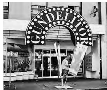
Im März 1978 wurde das Center Migros Gundelitor neu eröffnet. Im September 1997 war der grosse Umbau fertig. Foto: Archiv GZ.
