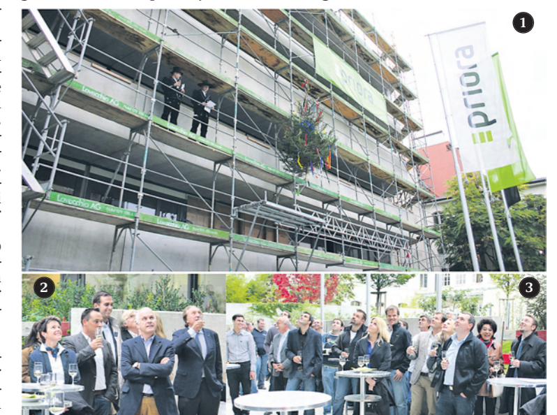
1-3) Investoren, Unternehmer, Architekten und Handwerker vom Sologarten 2 an der Güterstrasse 149 feierten vor kurzem - mit einem Richtspruch von zwei wackeren Zimmerleut' (Kurt Schaub und Robin Schwerdt) hoch oben auf dem Baurüst - ihre Aufrichte. Mehr Fotos von dieser Aufrichtefeier finden Sie auf Seite 30. Fotos: GZ
