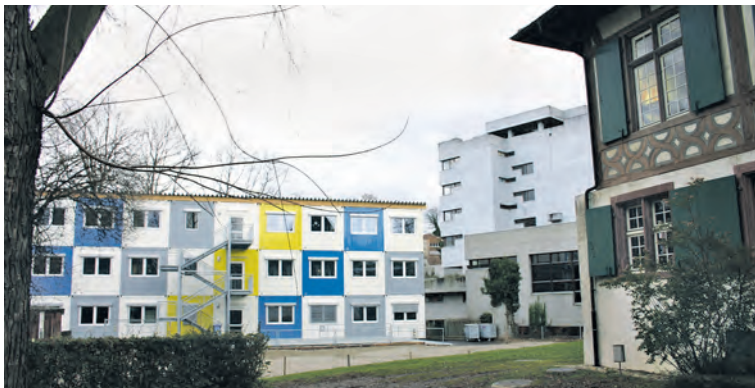
Das Brunnmattschulhaus (hi.) aus dem Jahre 1964 wird noch bis ca. anfangs 2014 totalsaniert (Energiesanierung, Brandschutzverbesserung, behindertengerecht, erdbebensicherer gemacht, etc.). Damit der Schulunterricht trotzdem am gleichen Standort problemlos weitergeführt werden kann, setzt das Erziehungsdepartement Basel-Stadt (zum ersten Mal) die extra für Schulhausumbauten angeschaffenen farbigen «Klassenzimmer-Container» ein. - Jetzt ist unser Wahrzeichen - das Thomas Platterhaus (re.) noch mehr verdeckt... Foto: GZ.
