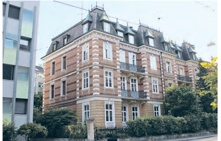
Eine Augenweide für viele Anwohner ist dieser über 100 Jahre alte Wohnblock an der Gundeldingerstrasse 428/430, der aber laut Angaben des neuen Besitzer sich in seinem Inneren in einem desolaten Zustand befindet und nicht mehr renoviert werden kann. Deshalb hat er ein Abbruch- und Neubaugesuch eingereicht. Foto: GZ.
