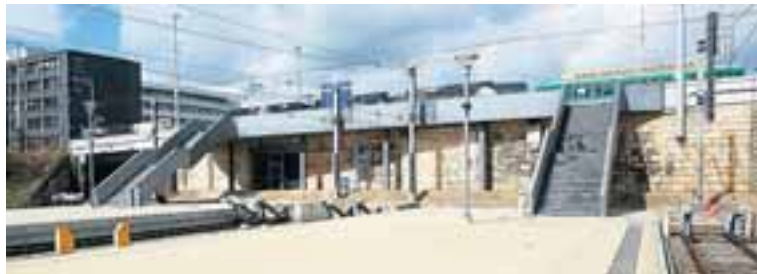
Keine Ausweichmöglichkeit für Gehbehinderte: Die beiden neuen SBB-Zugangstreppe. Foto: Benno Hunziker.
