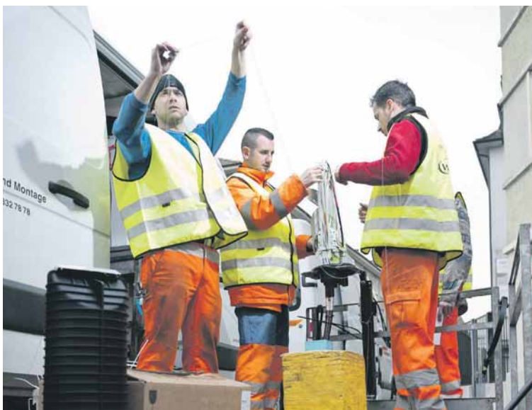
Monteure kontrollieren die Glasfasern vor der Verlegung. (Bild: Christian Flierl)
