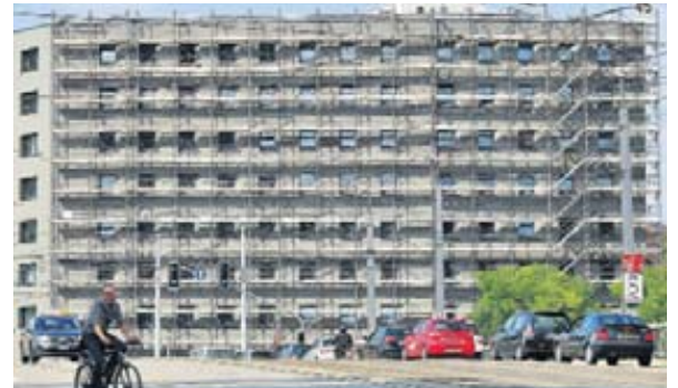
Anfangs August wurde das Hotel Ibis Budget und Novotel nochmals eingerüstet...
