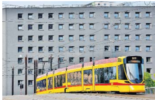
Im Juli zeigte sich zum ersten Mal die Fassade nach abmontiertem Gerüst...
