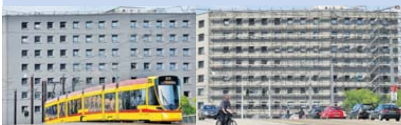
Im Juli zeigte sich zum ersten Mal die Fassade nach abmontiertem Gerüst...
