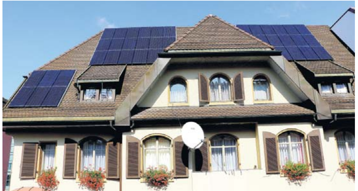
Die neue Solaranlage auf dem Dach des Restaurants Bundesbähnli an der Hochstrasse im Gundeli...
