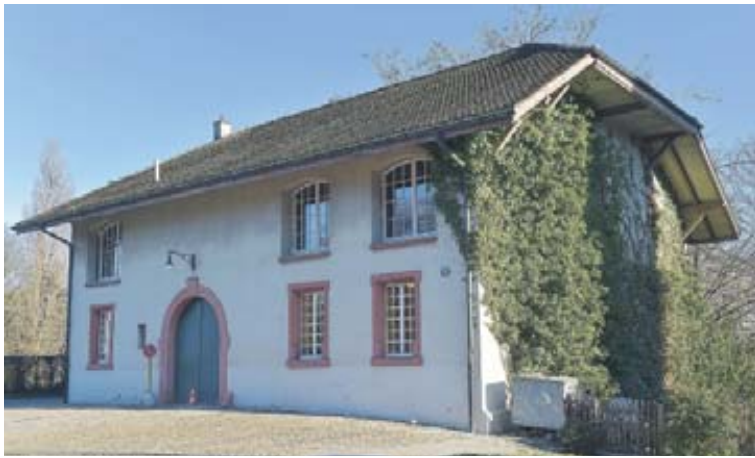
In dieser Liegenschaft am Walkeweg 122, auf Sichtweite des St. Jakob-Park, hat sich das Familientheater Arlecchino neu eingerichtet und damit dem Gundeli zu einer neuen Kulturstätte verholfen. Foto: J. Zimmermann
