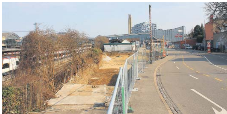
Hier sind die Vorbereitungen für die Verlegung der Meret Oppenheim-Strasse bereits voll im Gange. Foto: GZ
