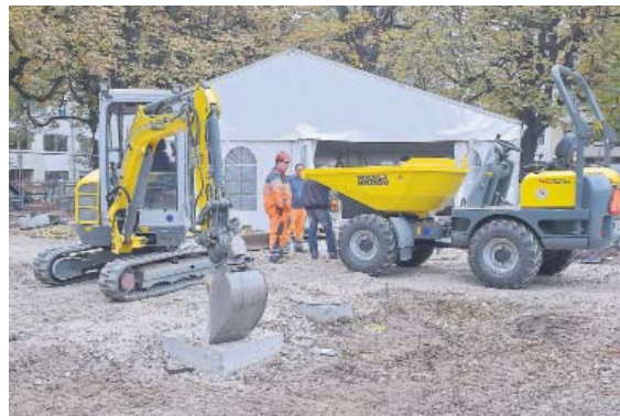
Im Zelt auf der Grossbaustelle wird am Entstehen der Gluggerbahn gearbeitet
