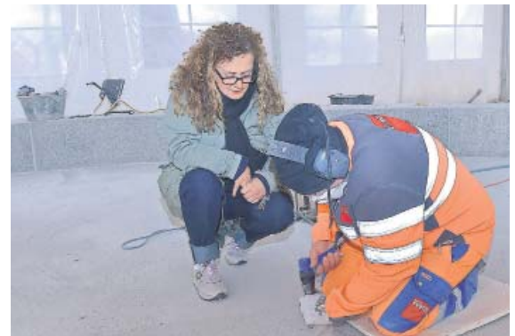
Anna Amadio beobachtet genau, wie die Gluggerbahnen in den Beton gefräst werden
