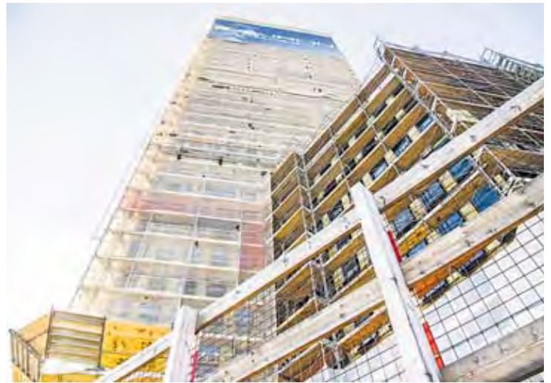
Jetzt wird intensiv an der Fassadenverkleidung und der zu integrierenden Photovoltaikanlage gearbeitet. Foto: Bianca Ott
