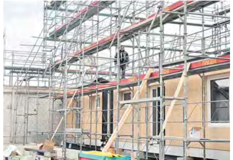
Die neue dreistöckige Frontpartie gegen den Walkeweg ist am Aufbau.
