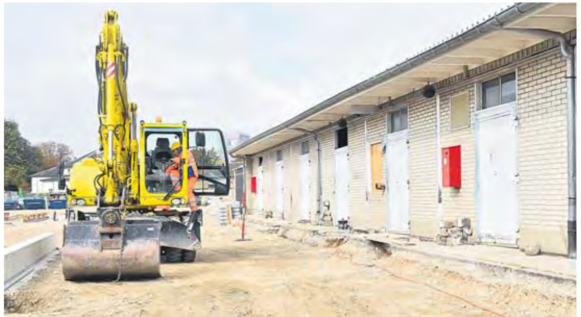
Fortsetzung auf Seite 4 Im früheren BVB-Lagergebäude werden die Heizung, Waschküche und Lagerräume installiert. Foto: Jos. Zimmermann
