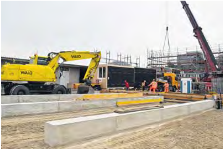
Im Stundentakt wurden die Wohncontainer auf den Betonfundamenten platziert.
