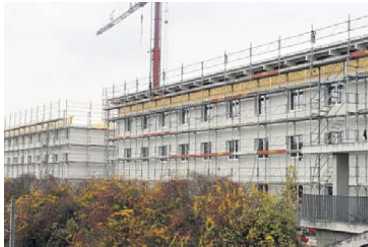
So präsentiert sich jetzt, das sich im Endausbau befindliche, Flüchtlingsdorf.
