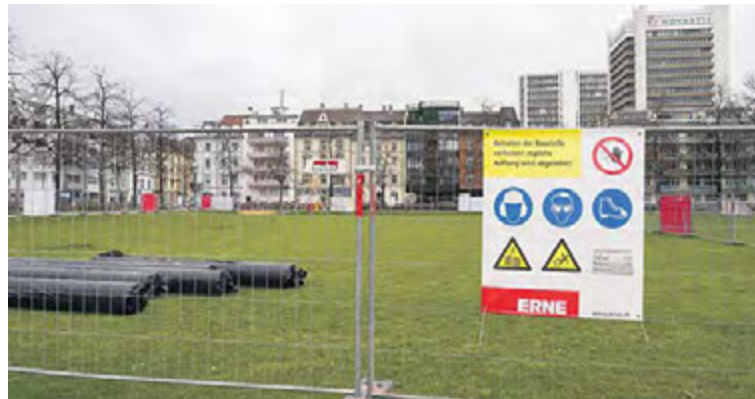
Die Vorbereitungsarbeiten für den provisorischen Schul-Campus sind seit einigen Tagen im Gange. Foto: GZ
