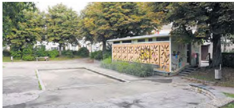
Was geschieht mit dieser alten Trafostation? Das Kernproblem beim Umgestalten des beliebten Quartiertreffpunktes. Foto: Philip Karger
