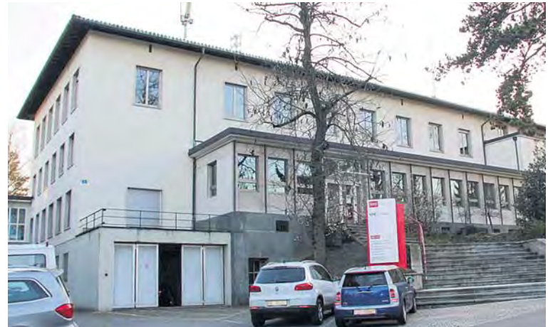
Bald wird das Radio Studio Basel abgerissen und die SRG-MitarbeiterInnen zügeln in das in Bau stehende Meret Oppenheim Hochhaus - MOH. Fotos: GZ
