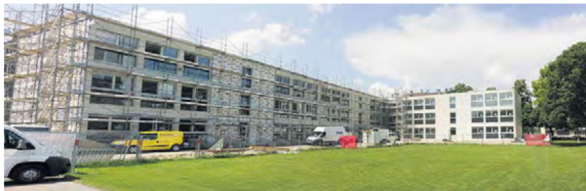
Das Schulprovisorium im Bau, von Nord-Ost her fotografiert.
