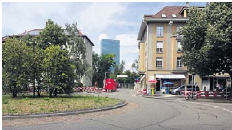
Frohe Kunde für Anwohner und vor allem für die Gewerbetreibenden: Die stadtbasler Regierung hat grünes Licht für den dringend nötigen Bau gegeben. Foto: WB
