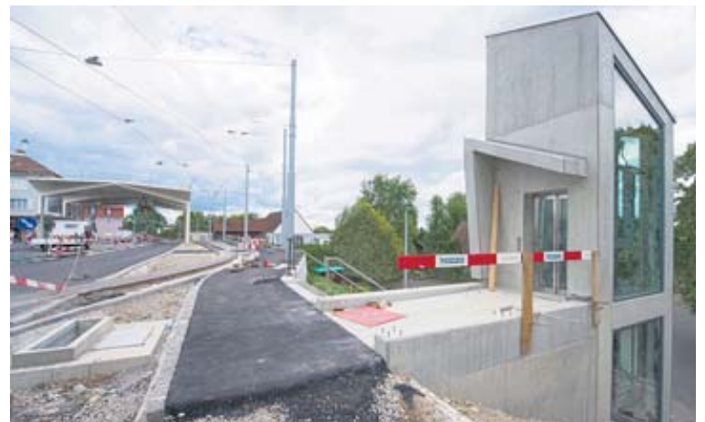
Vor der Tramhaltestelle beim neugebauten Zoll, mit Tramschleife und Abzweigung nach St. Louis, gibt es eine Treppe und einen behindertengerechten Lift für Anwohner und die Menschen aus dem REHAB.
