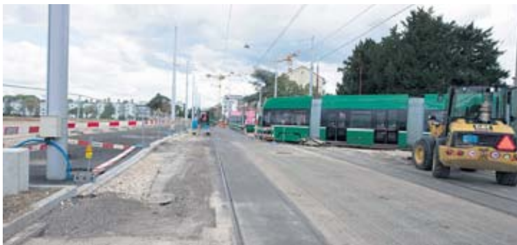
Eines der letzten Trams die an der alten Wendeschleife drehen. Hier kommen die neuen behindertengerechten Haltestellen hin, die auch durch ein Lichtsignal gesichert werden.
