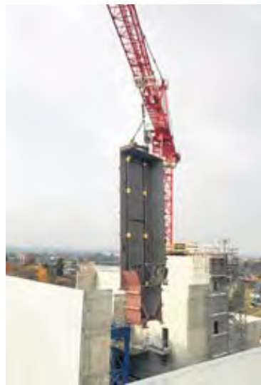
Ein Teil des Dampfkessels für das neue Holzkraftwerkes wird eingebaut.
