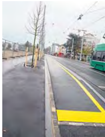
Ausgerechnet bei der Tramhaltestelle verläuft der Veloweg erhöht.
