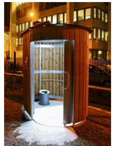
Der grösste und wichtigste Wunsch aus der Bevölkerung und Nachbarschaft: eine WC-Anlage: Nun hat der Spiel- und Freizeitplatz Hochstrasse eine nigelnagelneue Trockentoilette bekommen. Jupii!
