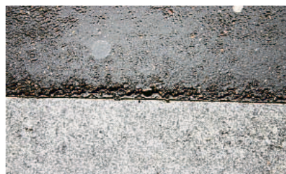
Auch die gefährlichen «Velofallen», der Spalt zwischen Teer- und Granitbeläge die im Winter wieder aufklaffen, sollen gemäss Planer verschwinden.
