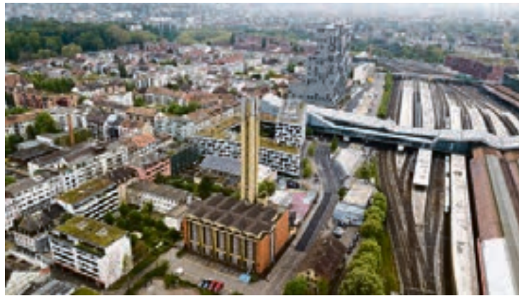
Luftaufnahme des Fernheizwerkes «Bahnhof» an der Solothurnerstrasse/Ecke Meret Oppenheim-Strasse im Gundeli, Richtung Westen.
