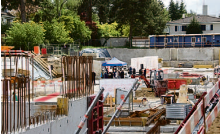
Die heutige Baugrube an der Novarastrasse. Im Hintergrund die versammelte Gesellschaft der Grundsteinlegung und ...
