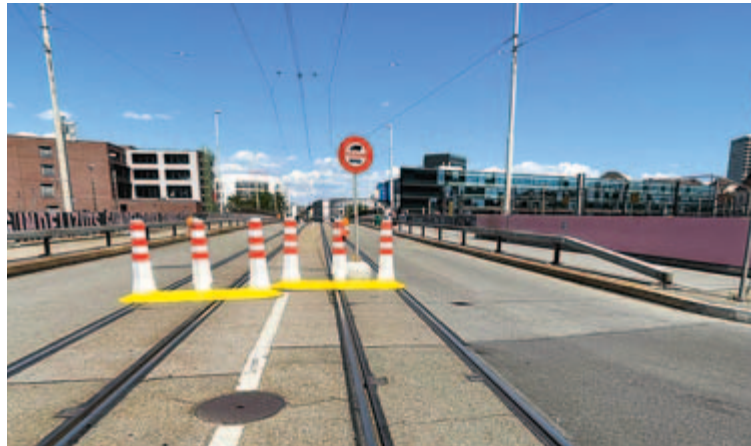
Seit einigen Wochen ist die Margarethenbrücke für Trams, Busse und Lastwagen gesperrt. Wie weiter? Thomas P. Weber
