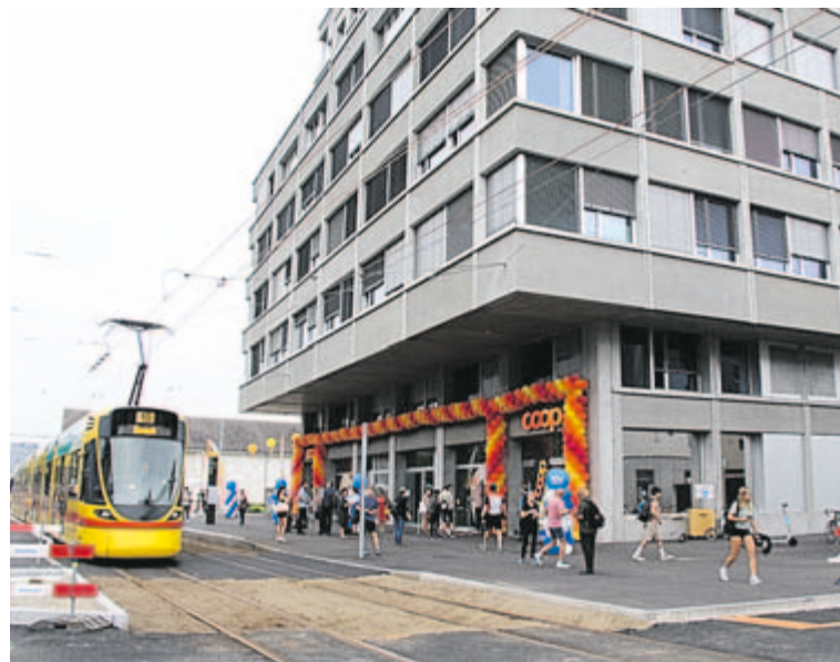
Die neue Coop Filiale Irène Zurkinden-Platz beim Dreispitz Verkehrs-Knoten.
