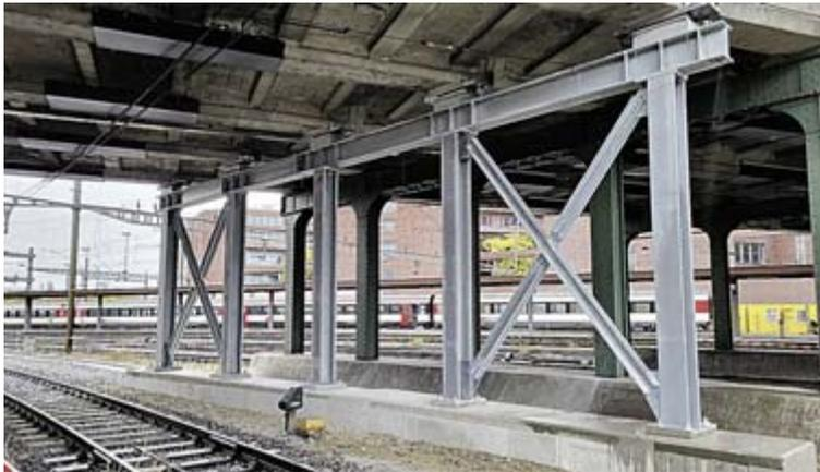
Das Foto vom 2. November 2023 zeigt eine der sechs provisorischen Stützenreihen. Dahinter ist eine der bestehenden Pfeilerreihen erkennbar. Foto: zVg/SBB
