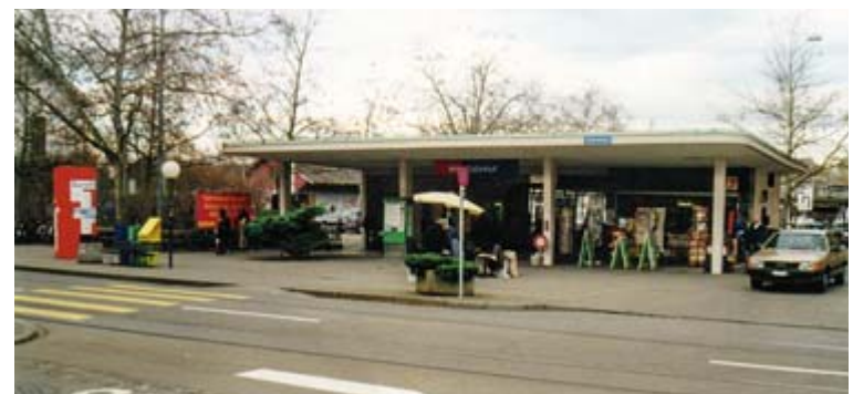
Wo heute die Passerelle steht, war bis anfangs 2001 der Eingang zur SBB-Unterführung. Foto: Archiv GZ
