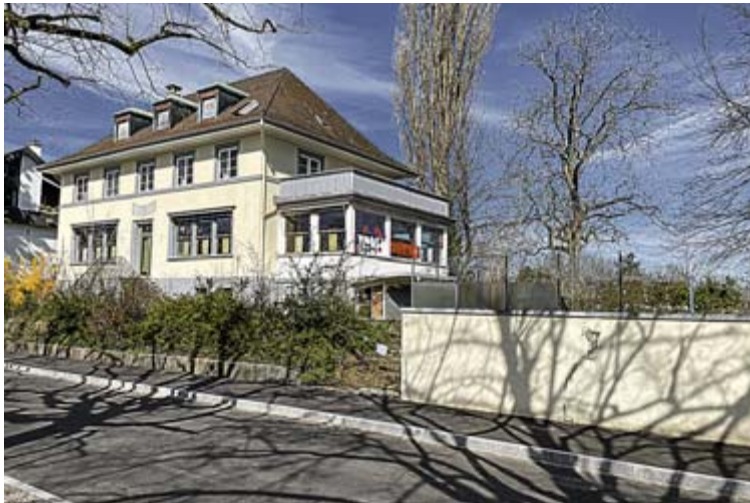
Wann wird im ehemaligen Restaurant La Torre wieder fröhlicher Gastronomie- oder sogar Kulturbetrieb herrschen? Die Antwort auf diese Frage steht derzeit noch in den Sternen.
