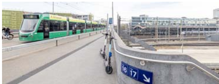
An den Zugängen der Margarethenbrücke werden bald Höhenbegrenzungsbalken installiert. Foto: zVg
