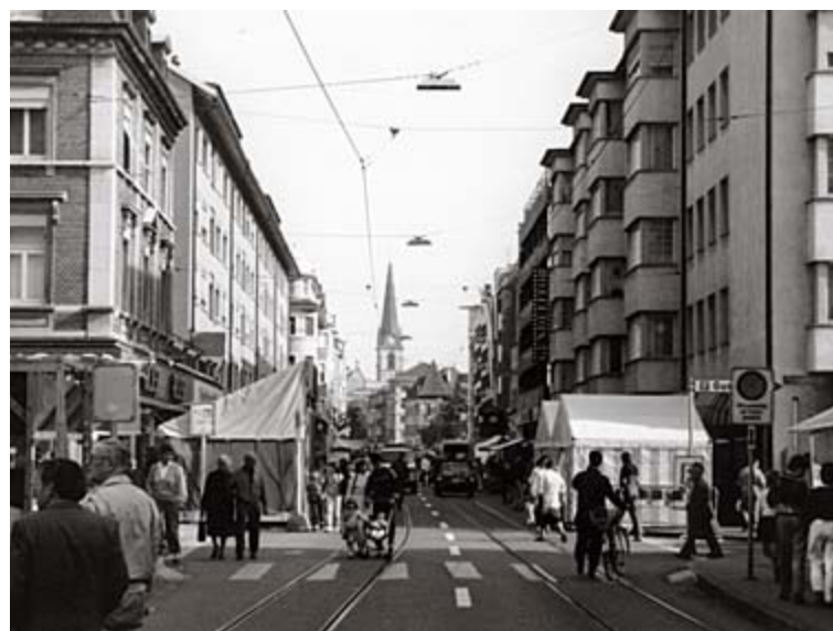
Gundeli-Fescht 1986, Güterstrasse, auf der Höhe Pfeffingerstrasse.
