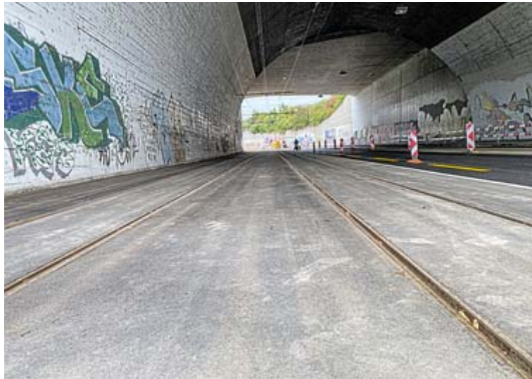
St. Jakobstrasse – das Ende ist in Sicht.
