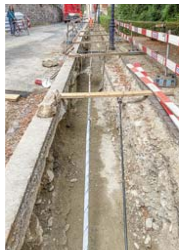
Kanalarbeiten am Mühleberg.
